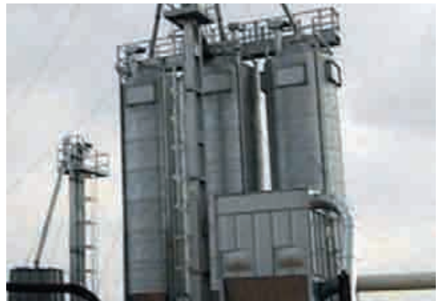
Figura 20 - Interior de silos, tolvas...
